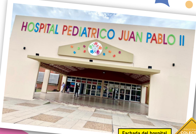
Fachada del hospital.
